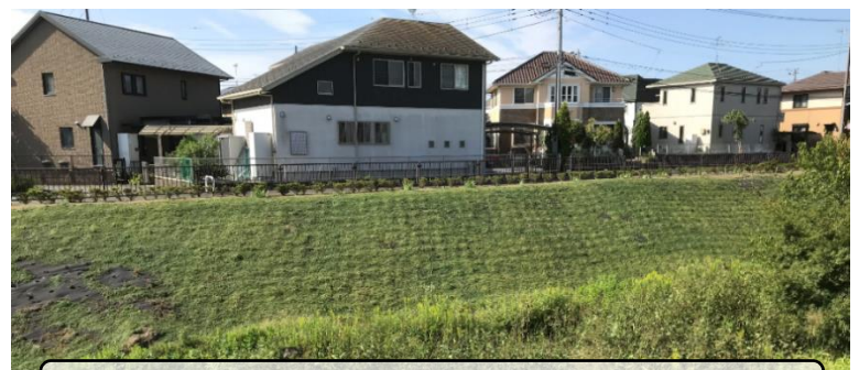
古城橋下流南側法面に3月に植えたクラピアは生育良好
